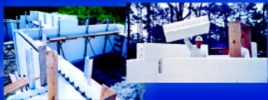
Cofraje modulare termoizolante din polistiren expandat - sistem Amvic
